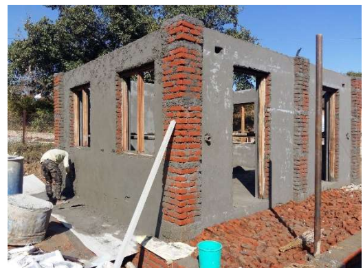
建設中の図書館 (バル・プラティバ・ベーシック学校)
